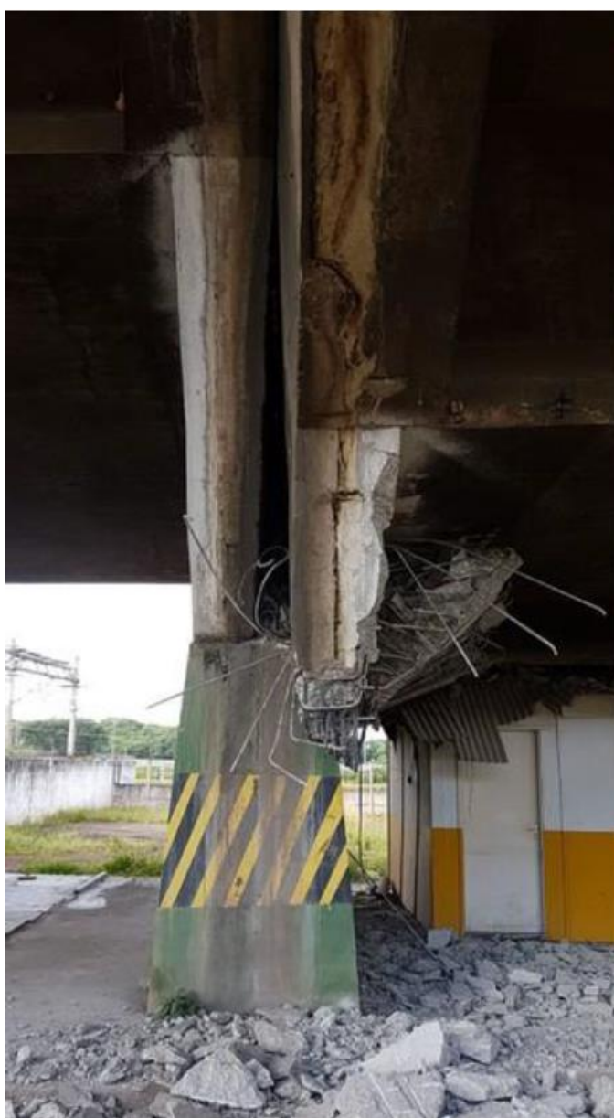
Figura 1626: Pilar e transversina após o colapso (EGT Engenharia).
