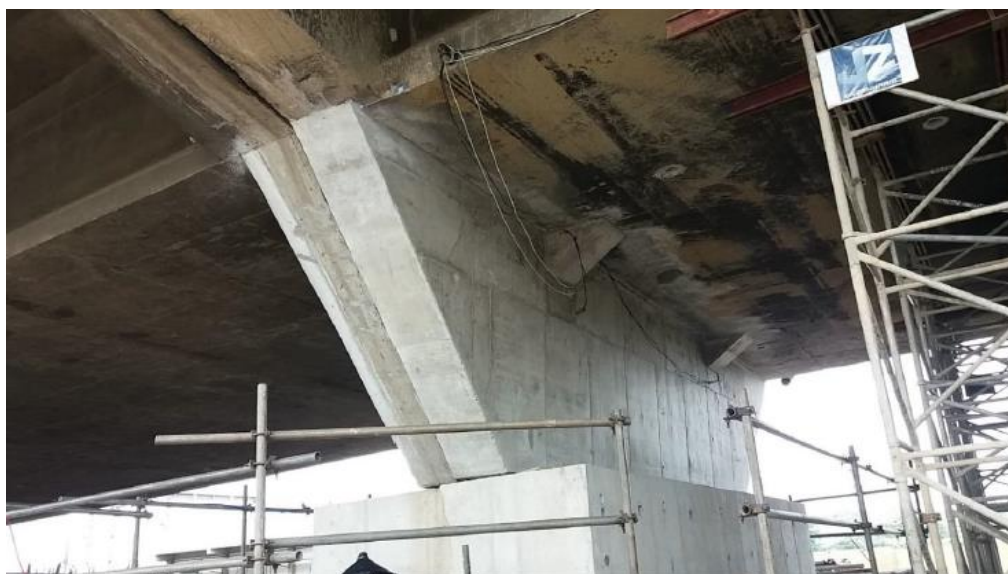
Figura 36: Transversina restaurada (EGT Engenharia).
