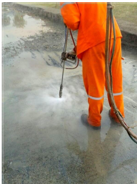
Figura 4: Limpeza com jateamento de água (Rental Pumps).
