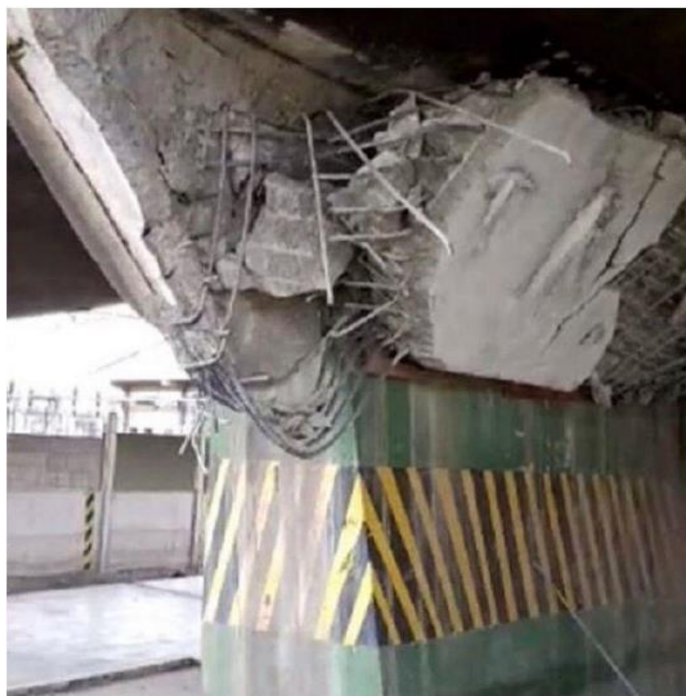
Figura 19: Detalhe da transversina rompida (EGT Engenharia).
