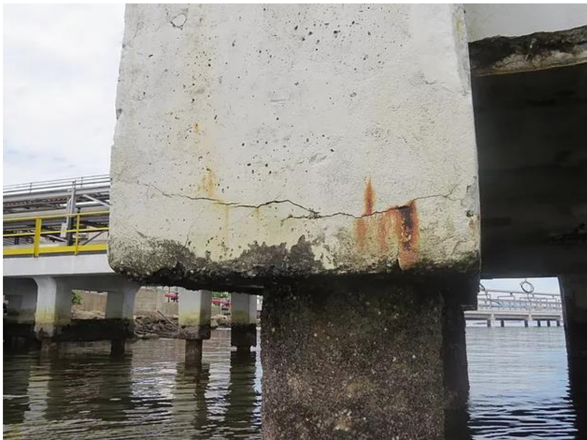
Figura 3: Estrutura com fissuração devido à corrosão gerada pela presença de cloretos (Axfiber).
