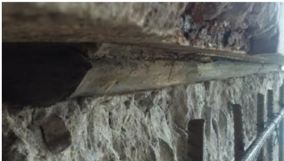
Figura 290: Detalhe do aparelho de apoio (EGT Engenharia).
