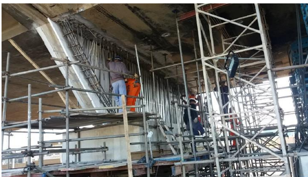
Figura 35: Foto da recomposição da transversina (EGT Engenharia).
