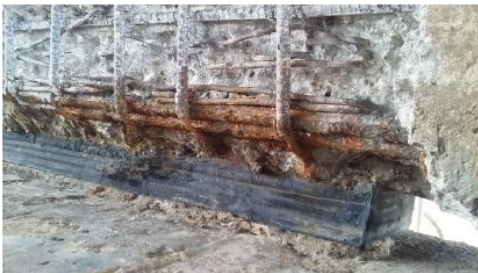
Figura 301: Corrosão da armadura na região do apoio (EGT Engenharia).
