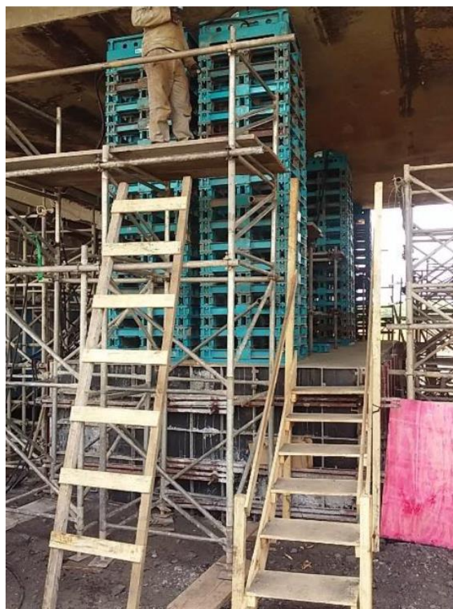
Figura 345: Foto da estrutura de macaqueamento (EGT Engenharia).
