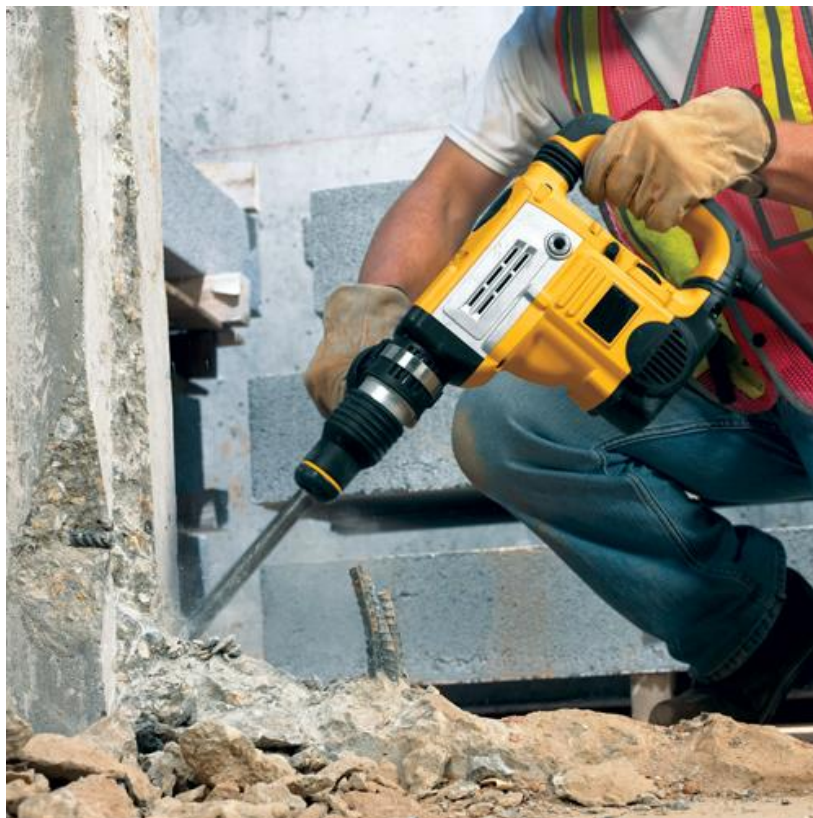
Figura 5: Remoção de concreto com martelete (Casa do Construtor).
