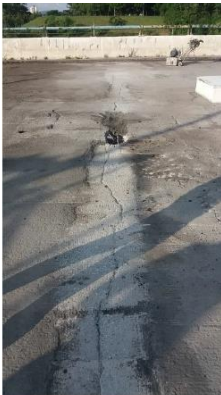
Figura 37: Fissura na laje superior do tabuleiro (EGT Engenharia).
