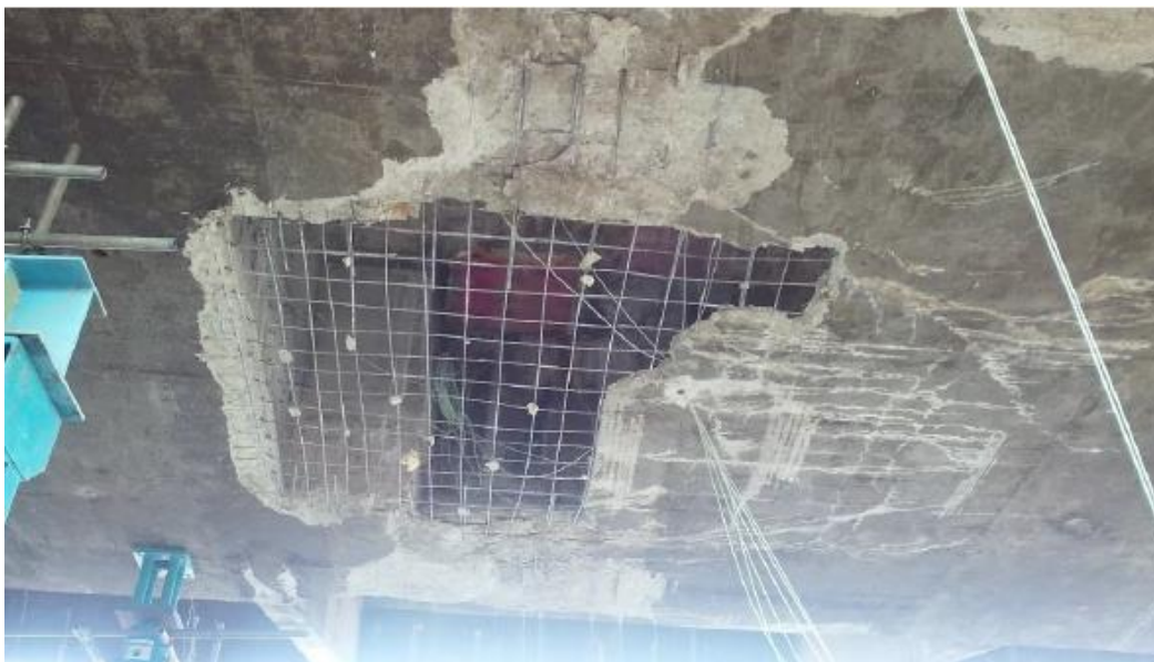
Figura 38: Rompimento na laje inferior da seção (EGT Engenharia).
