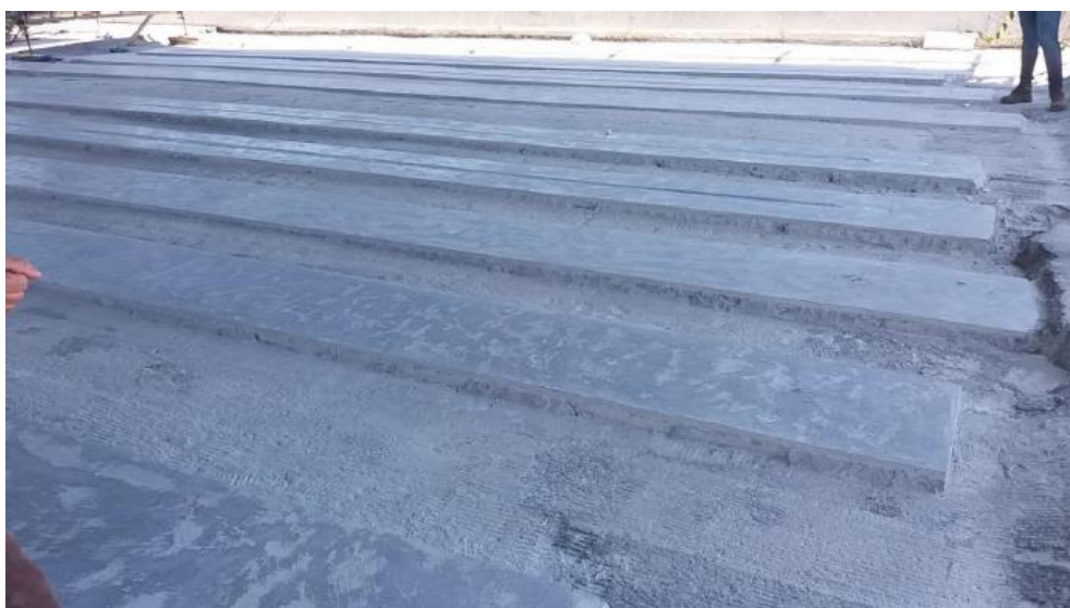
Figura 39: Preparação do substrato para aplicação do reforço com PRFC (EGT Engenharia).
